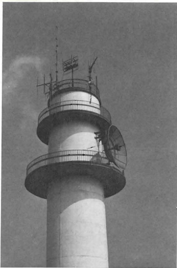
Fig. 17. — Torre in cemento armato generalmente usata per l'installazione dei ripetitori.
