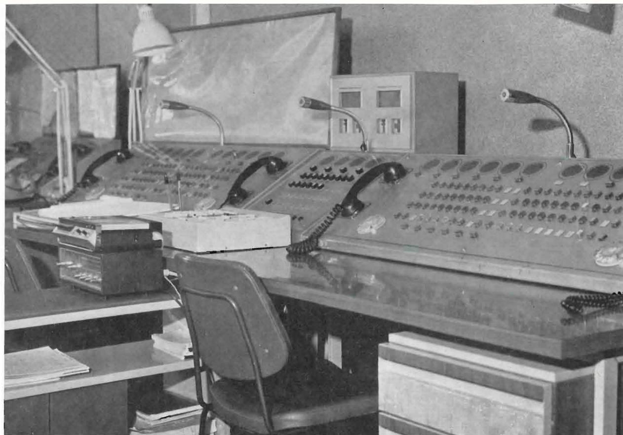
Fig. 3. — Sala radio di Direzione di Tronco. Tavolo di regia a due posti di operatore; sulla sinistra: tavolo di regia per Centro Operativo Autostradale (COA).
